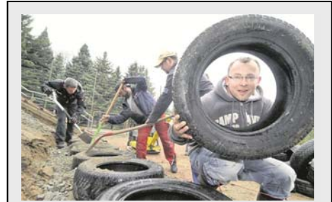
Von der Straße zur Kita Moosmutzelreich in Dürrröhrsdorf: Robert Zernisch hat zusammen mit anderen Eltern insgesamt 150 Autoreifen als Treppe in die Erde gesetzt. Sie festigen den Hang an der Kita. Foto: Dirk Zschiedrich
